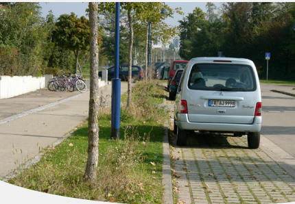
Modernes Grasfugenpflaster: Fugengrün erwünscht
